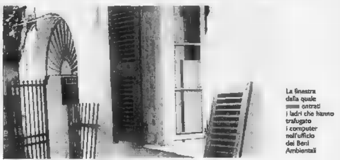
La finestra della quale entrarono i ladri che hanno trafugato i computer nell'ufficio dei Beni Ambientali
